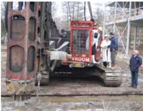
De eerste paal voor de sporthal naast het bovenbouwgebouw van Panta Rhei.
