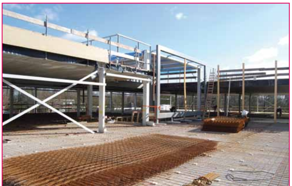
De voorbereidingen voor het storten van de vloeren zijn in volle gang. De foto is begin maart 2010 genomen op de eerste etage.
